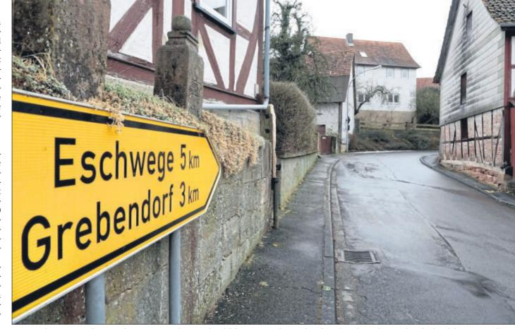
Hier wird es eng werden: Mit der Sanierung der Ortsdurchfahrt Neuerode werden die schmalen Schrammborde durch breitere Gehwege ersetzt. Das geht zu Lasten der Fahrbahnbreite, wo an Engstellen dann kein Begegnungsverkehr mehr möglich ist.
